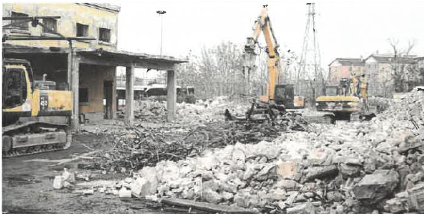
La demolizione dell'ex mercato ortofrutticolo. FOTO ANSA
